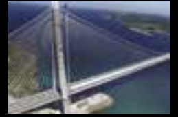
3. Köprü ve Kuzey Çevre Otoyolu
